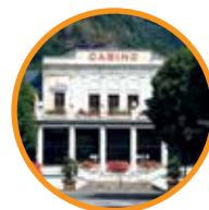
Entretien général du bâtiment
