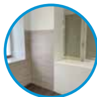
Restauration des loges
