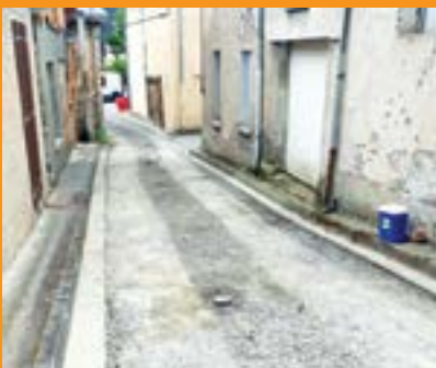
Terrassement rue de la liberté.
