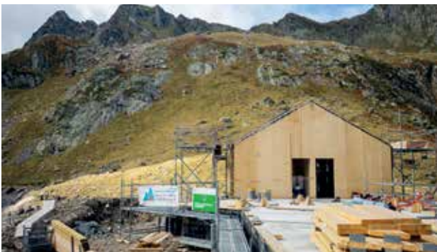
Travaux du refuge (Octobre 2021).
