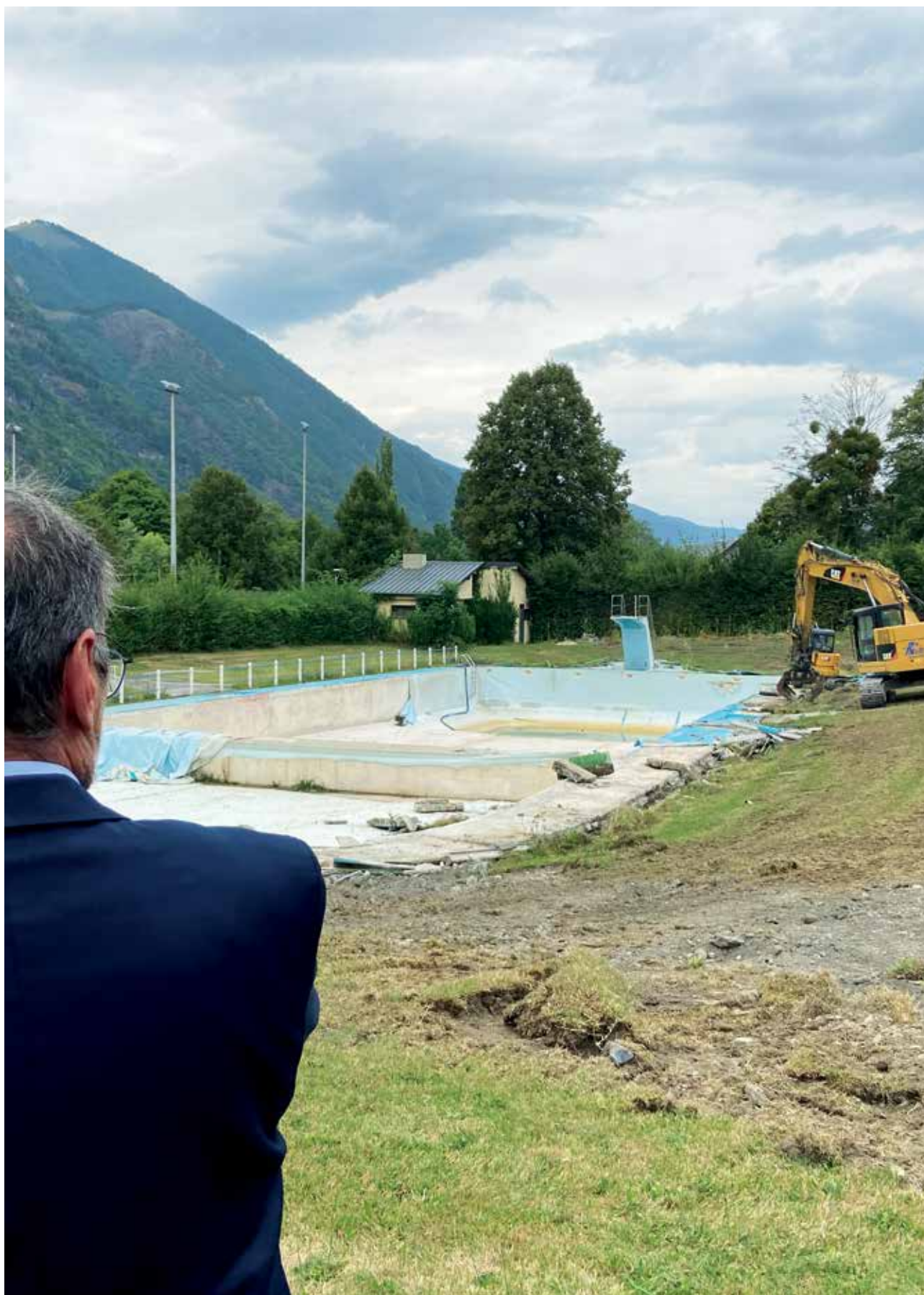
Début de la démolition de la piscine en présence de M. le Maire.
