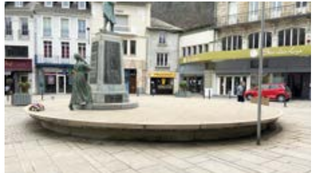
Avant les travaux de la place Joffre
