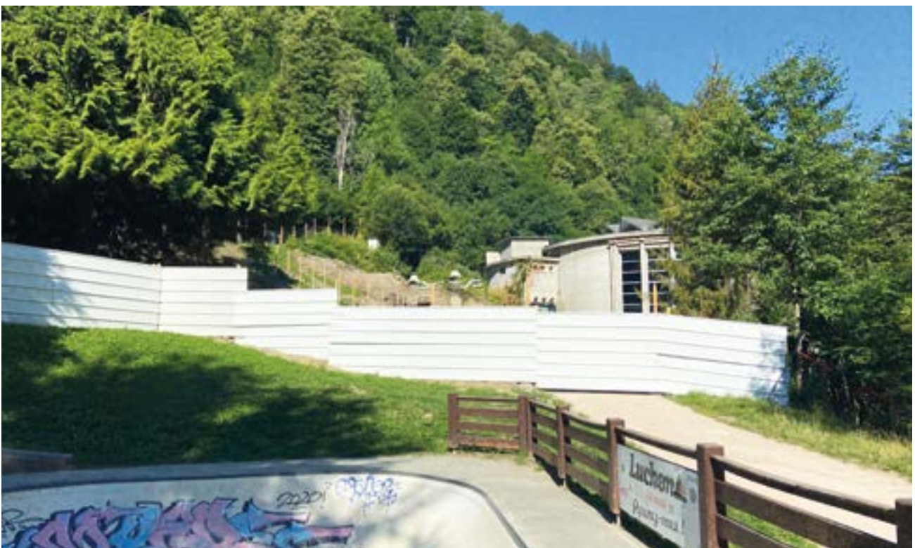
Travaux de l'extension des Thermes de Luchon
