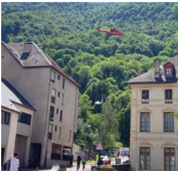
Démontage des pylônes de l'ancien téléporté
